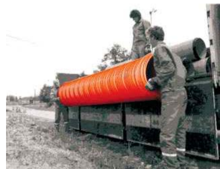
Ręczny rozładunek rur Pragma®
