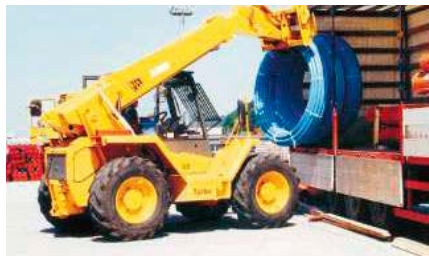
Rozładunek wiązki rur PE za pomocą wózka widłowego
