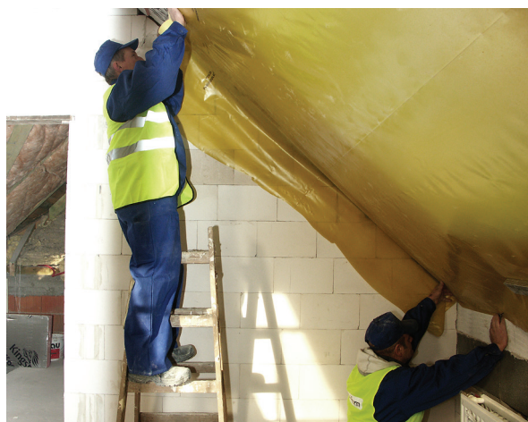
Zdj. 2. Montaż folii paroizolacyjnej.
