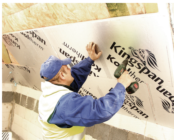
Zdj. 1. Wstępny montaż płyt Kooltherm® K12 Izolacja wewnętrzna.
