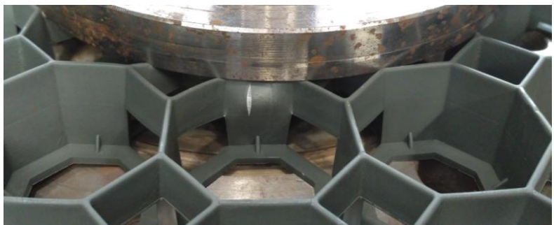
Abb.3: plastische Verformung/Zerstörung der Stege
